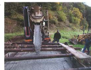
Rénovation du pont de Brangra en régie communale
