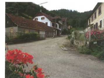
Rénovation de la rue de Hargoutte
