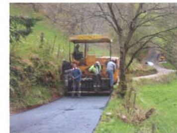
Pose d'enrobé chemin de Biagoutte
