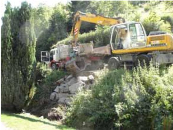
Mise en place d'encochement pour consolider le talus du chemin de Pierreusegoutte
