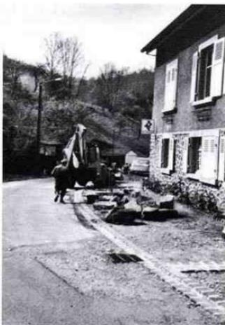
Construction d'un muret en grès des Vosges par les ouvriers communaux
