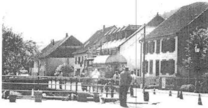
Pose des enrobés sur les trottoirs le long du Rombach
