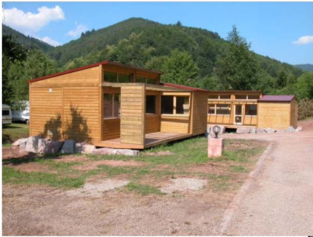
Les chalets mis en place au camping « Les Bouleaux »
