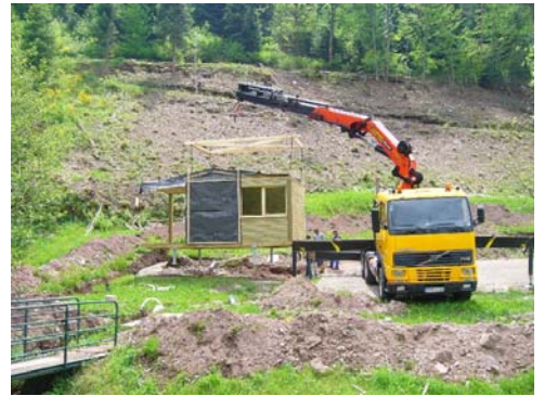
Les éléments en cours d'assemblage
