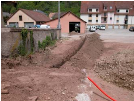
Travaux de mise en souterrain des réseaux place des fêtes
