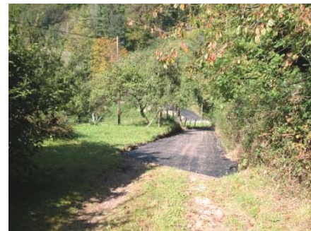
Pose d'enrobé sur des chemins communaux à Naugigoutte
