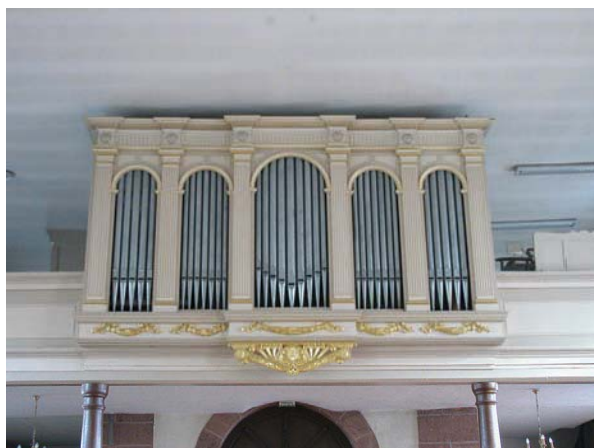
Les tuyaux de montre en zinc seront remplacés par des tuyaux en étain identiques à ceux réquisitionnés par les Allemands en 1917.
