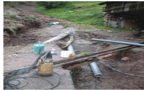
Assainissement et adduction d'eau potable pour le Feignet
