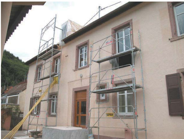
Construction des issues de secours
