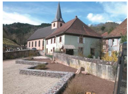
Aménagement paysager place des fêtes avec création de places de parking
