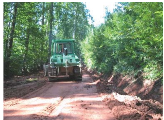
Réfection du chemin forestier de la Vaurière
