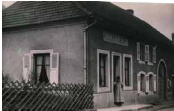
Restaurant Augustin Aubry avant l'incendie
