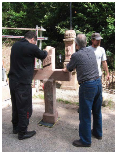
Préparation de la croix réparée
