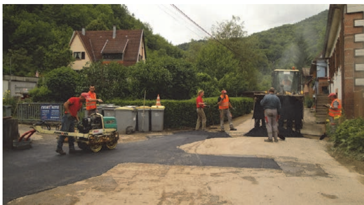
Réfection des enrobés de la route de la Hingrie
