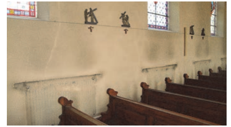
Après la dépose des anciens radiateurs
