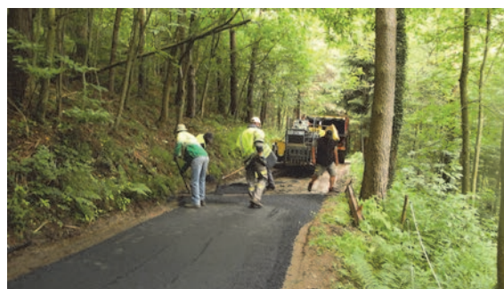
Pose d'enrobé dans le fond de Naugigoutte
