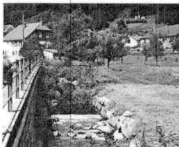
Stabilisation du lit du Rombach
