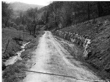
Travaux d'élargissement du chemin de Pierreusegoutte
