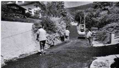
Pose des enrobés rue de la Vaurière
