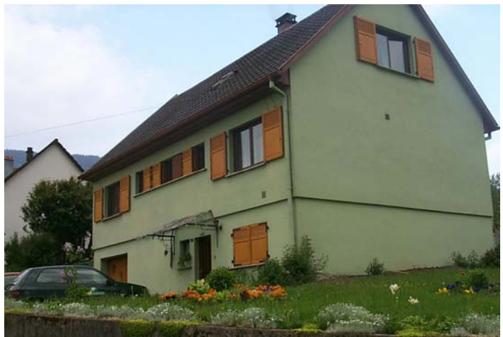
De nouvelles fenêtres et des volets en bois à la maison forestière
