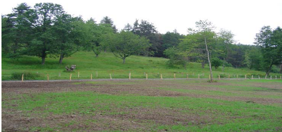
Travaux d'amélioration pastorale en cours
