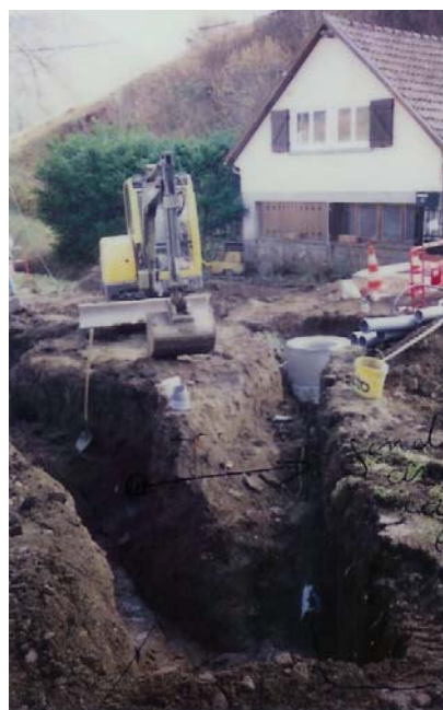
Travaux d'assainissement à l'arrière de l'église permettant le raccordement de six habitations.
