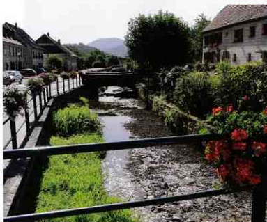
Curage du Rombach et plantation de plantes aquatiques en 2004. Le dernier curage s'est fait en 1994.
