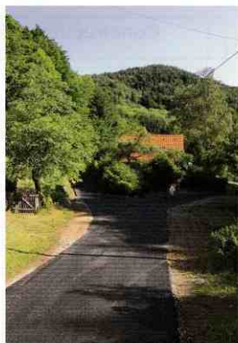
Réfection du chemin de Volbach et du Foa
